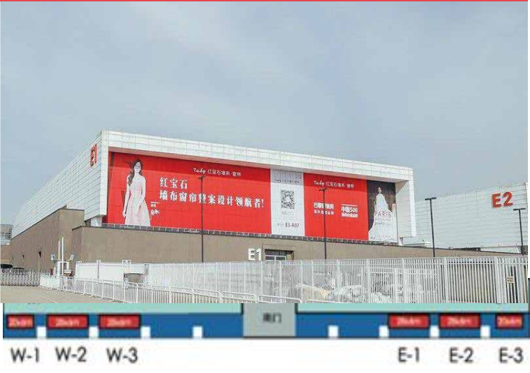
3.1-南广场南墙体
